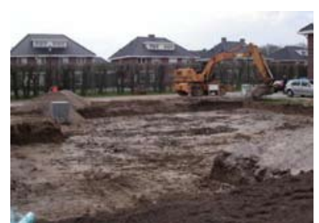
Bodemwerken in Cuijk
